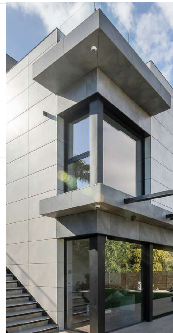
Edificio unifamiliar. Arq. Víctor Blanco. Premià de Dalt, España.
